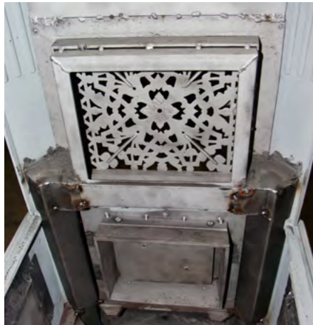
Raumluftunabhängige Frischluftzufuhr in Gestell-Kachelofen (Sicht von innen) zur Glastüre, um Russbeschlag zu verhindern.
